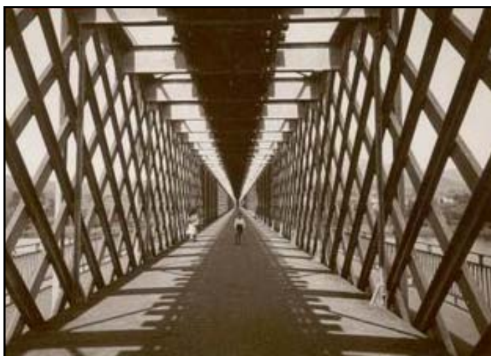
Interior da Ponte Internacional de Tui. Esquerda: imaxe durante a construción. Dereita: imaxe dunha postal de principios do século XX.
