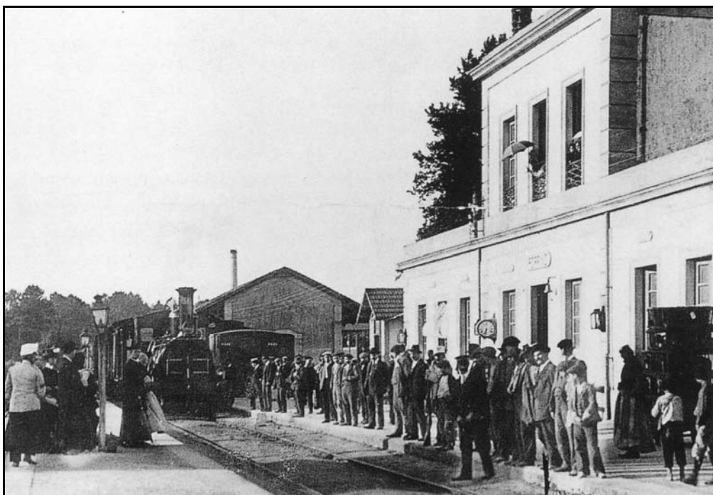
Estación do ferrocarril no Porriño.
