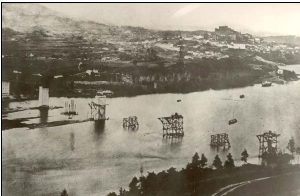
Ponte Internacional de Tui en construcción.
