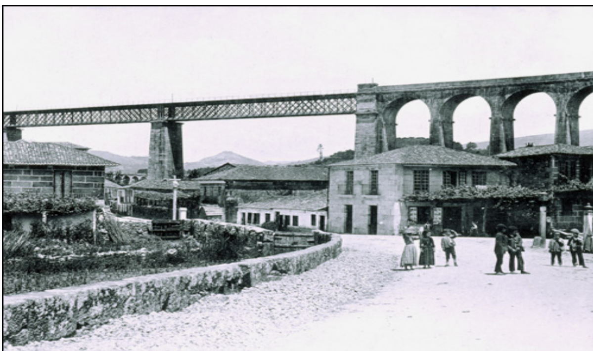
Viaducto do Redondela.
