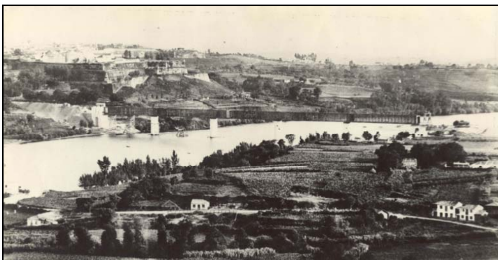
Ponte Internacional de Tui no tramo final da súa construcción.
