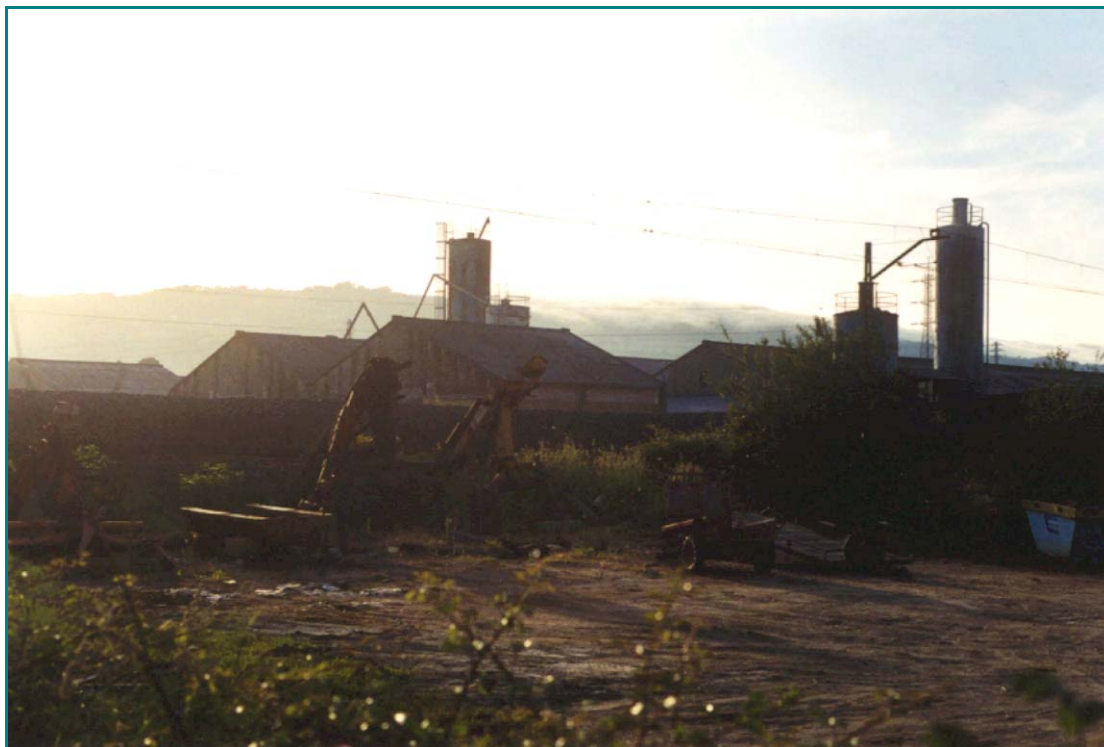
O tendido do ferrocarril no arrabalde industrial do Porriño.
