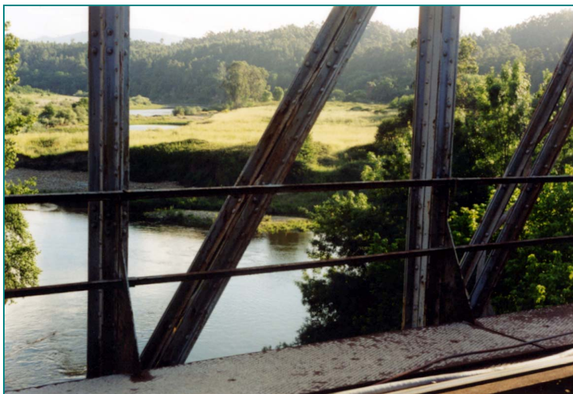
Ponte sobre o río Tea.
