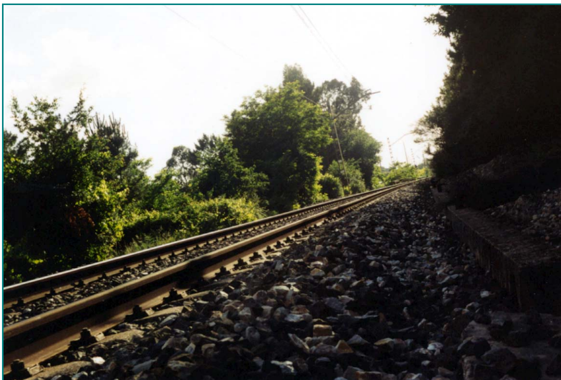
Vía e vexetación. Porto ( Salvaterra ).
