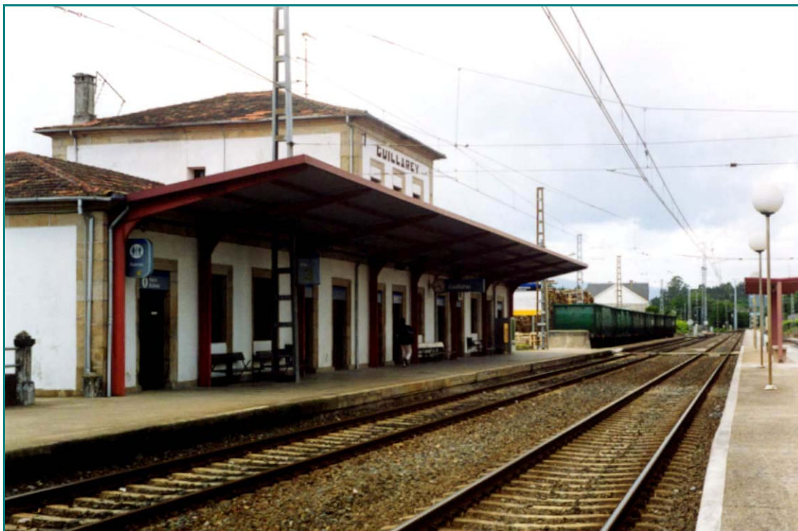
Estación de Guillarei.
