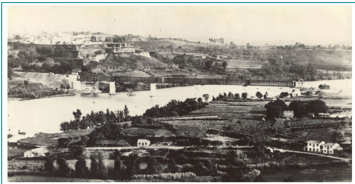
25. Ponte Internacional de Tui no tramo final da súa construción.
