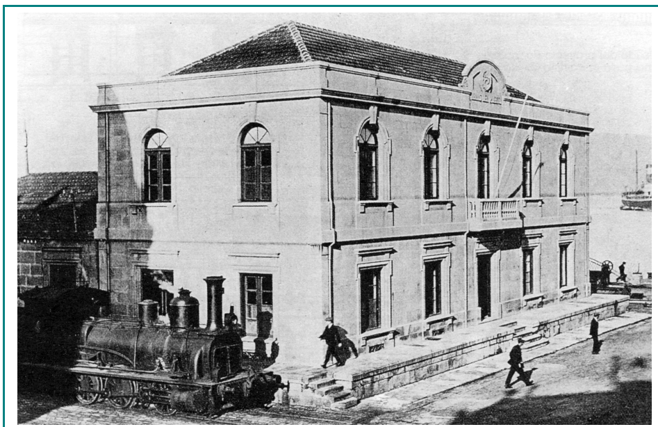
15. A locomotora nas instalacións portuarias de Vigo.
