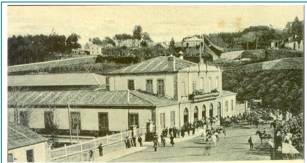
17. Estación do ferrocarril de Vigo antes da súa ampliación na fachada principal.
