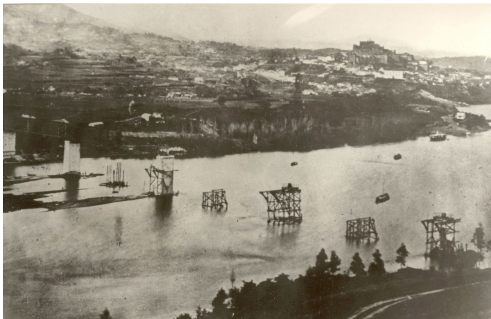
24. Ponte Internacional de Tui en construción.
