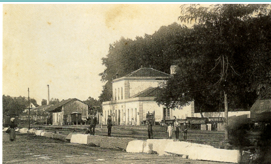
22. Estación do ferrocarril do Porriño, pouco tempo despois da súa construción. Aínda no rematara o peche exterior da estación.
