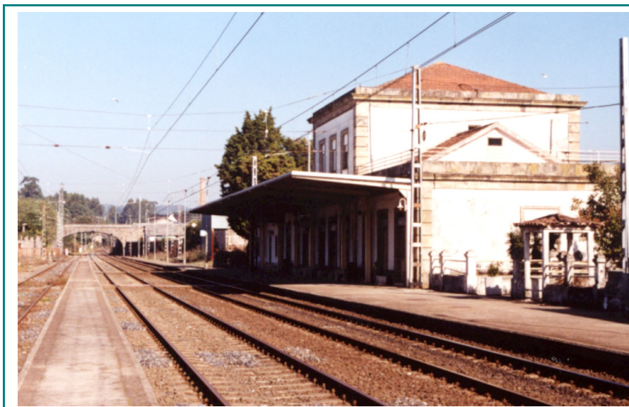
21. Estación do ferrocarril do Porriño. Fachada principal.
